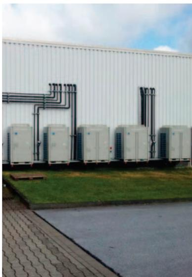
Шесть блоков Daikin ZEAS обеспечивают холодопроизводительность 74 кВт для замороженных пищевых продуктов, и еще шесть - холодопроизводительность 171 кВт для охлажденных пищевых продуктов.
